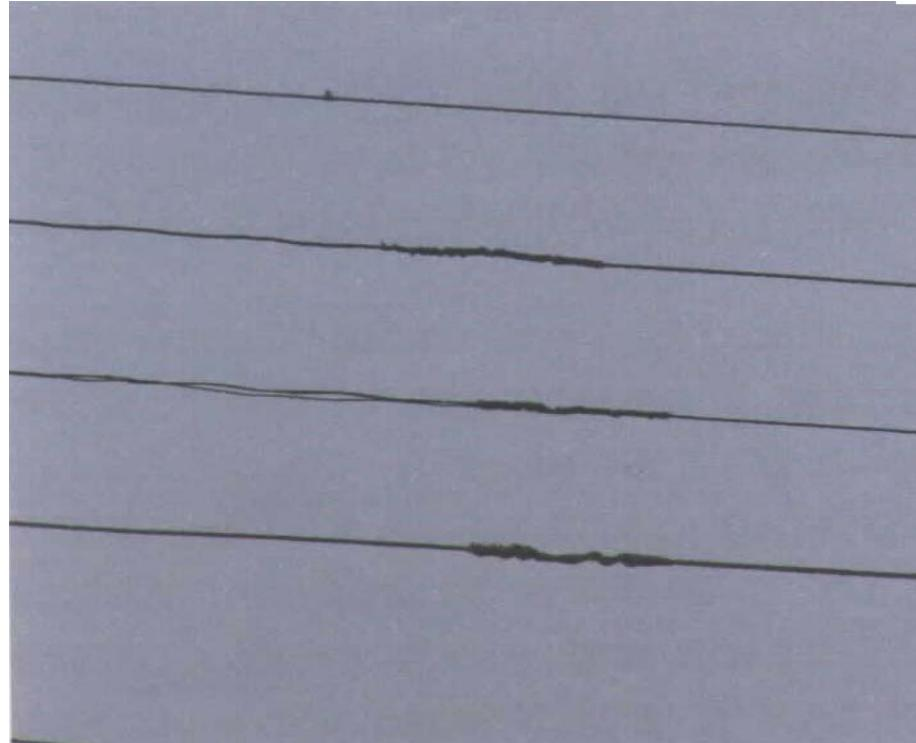
في حال وجود وصلات في الناقل يجبأخذ مقاومة الوصل بالحسبان، على سبيل المثال: تم قياس مقاومة وصلة في ناقل شبكة توتر منخفض حيث بلغت  $14 \mu\Omega$ . من أجل تيار  $1000 A$  يكون الفاقد السنوي في هذه الوصلة  $123 kWh$  سنوياً. وإذا علمنا بأن الشبكة تحوي على عشرات الآلاف من نقاط الوصل نأخذ صورة كافية عن كمية الضياعات في هذه الوصلات.
