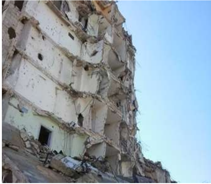
شكل /14/: الانهيار الجزئي لمبنى مكون من ثمانية طوابق
