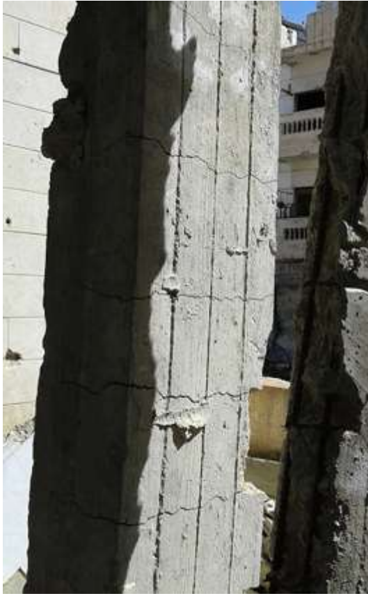
شكل /10/: التشوه المرن في العناصر الإنشائية والتشققات الحاصلة نتيجة الانفجار
