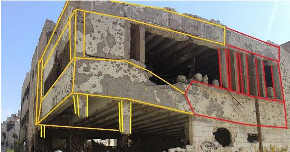
شكل /48/: تشققات عند نقاط تركيز الإجهادات بسبب تغير سلوك هيكل المدرج
