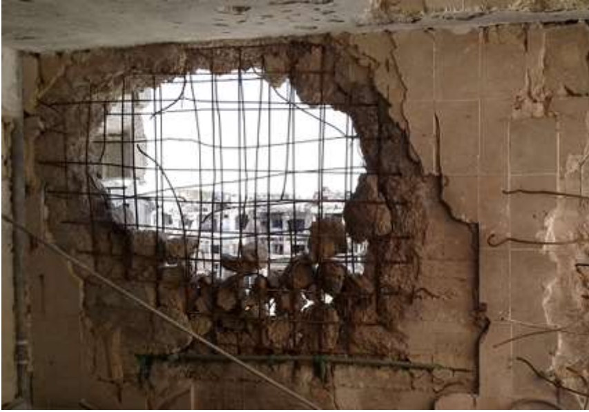
شكل/13/: التشظي في العناصر الإنشائية نتيجة الانفجارات
