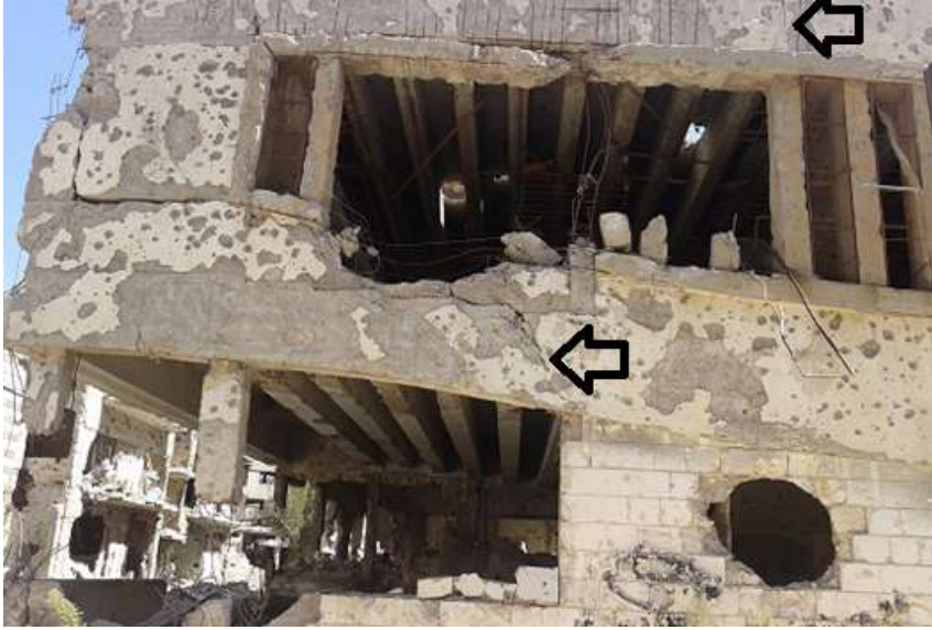
شكل /49/: تشققات عند نقاط تركيز الإجهادات بسبب تغير سلوك هيكل المدرج
