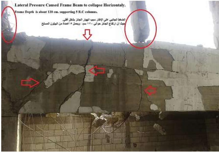
شكل /39/: التشوهات في العناصر المشكلة للإطار
