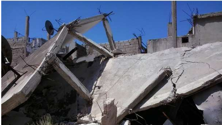
شكل /15/: انهيار مبنى مكون من طابق واحد نتيجة خروج الأعمدة عن الاستثمار
