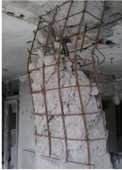
شكل /11/: شبكات التسليح المنتظمة ومساهمتها في مقاومة ضغط الانفجارات
