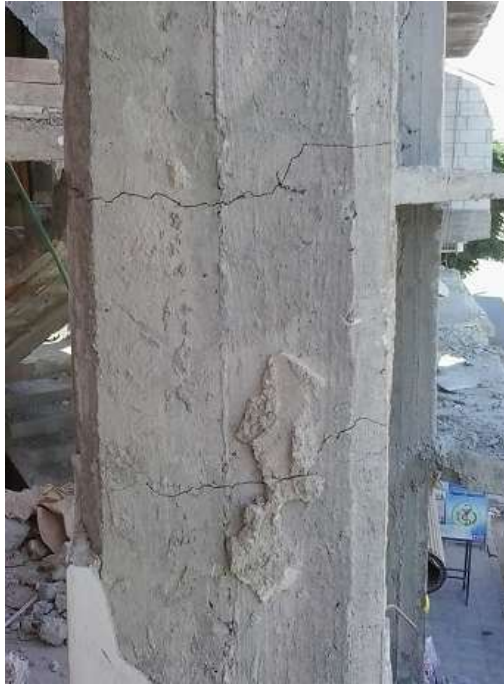
شكل /26/: التشققات الناجمة عن الشد بسبب انهيار العمود السفلي
