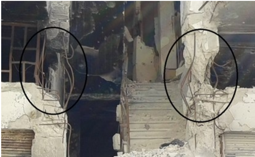
شكل /20/: تشوه فولاذ التسليح في عدة اتجاهات متباعدة بسبب التحنيب
