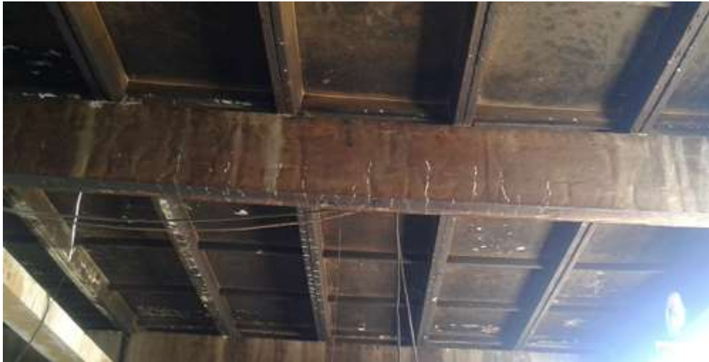
شكل /9/ : التشوه المرن في العناصر الإنشائية والتشققات الحاصلة نتيجة الانفجار
