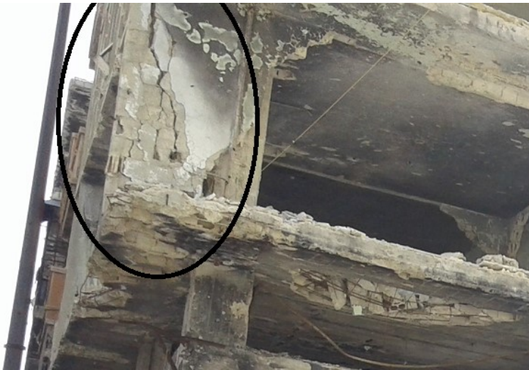
شكل /24/: التشققات المائلة في جدران الطوابق العلوية نتيجة تشوه البلاطة
