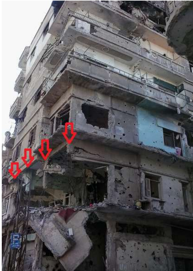
شكل /27/: انهيار صف الأعمدة الطرفية وخروجها كلياً عن الاستمرار
