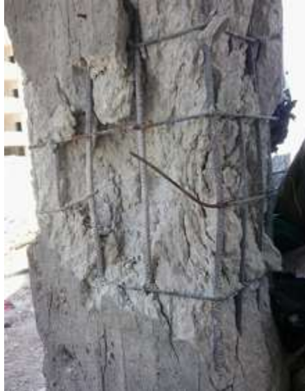
شكل /12/: التفقت وضياع المادة في العناصر الإنشائية نتيجة الانفجارات
