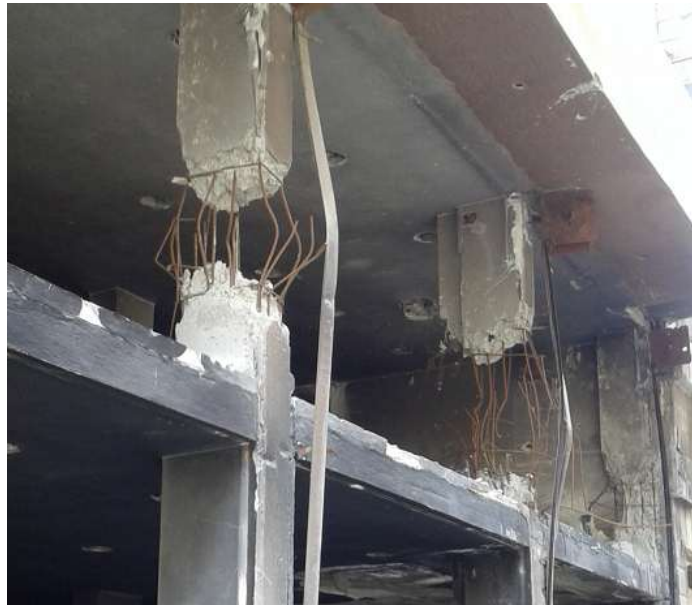
شكل /17/: تحنيب قضبان التسليح الطولي في الأعمدة نتيجة استمرار التشوه
