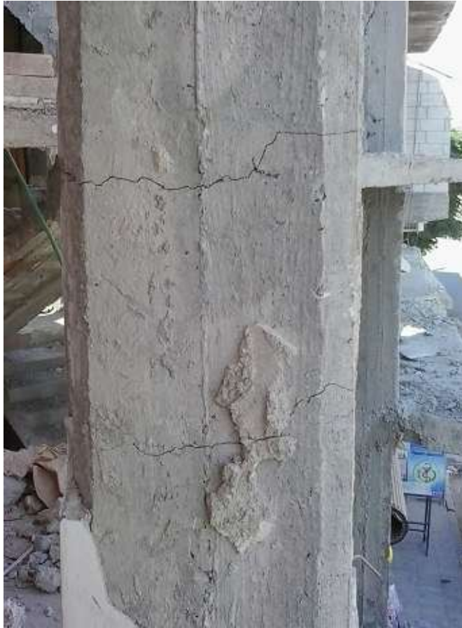
شكل /22/: التشققات الناجمة عن الشد بسبب انهيار العمود السفلي
